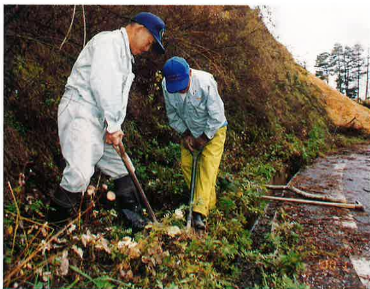
地震計設置作業
